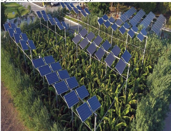
d. AGV system with banana (Pulipaka & Peparthy 2021).
